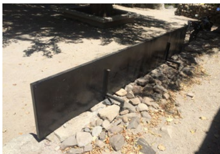
Imagen referencial 03: Estructura de soporte
