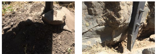
Imagenes referenciales fijación y empotramiento de señalética
