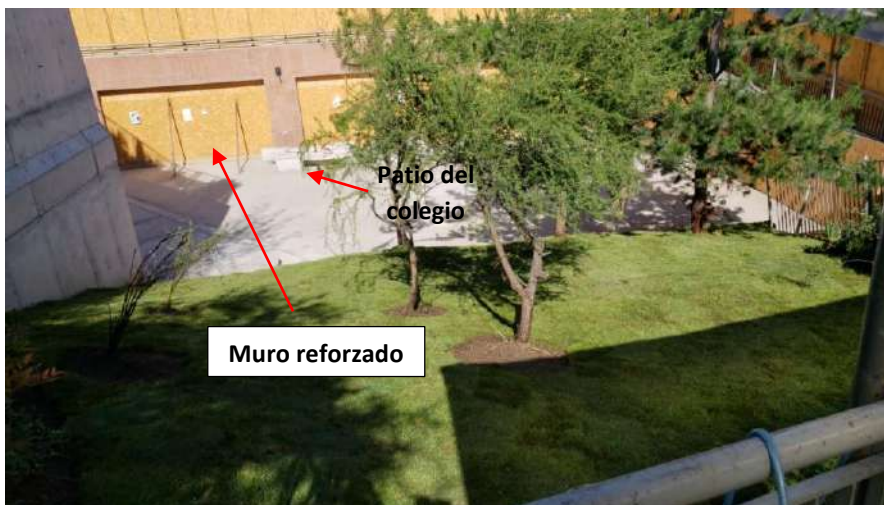
Figura: Muro de contención – Vista la entrada superior del colegio
