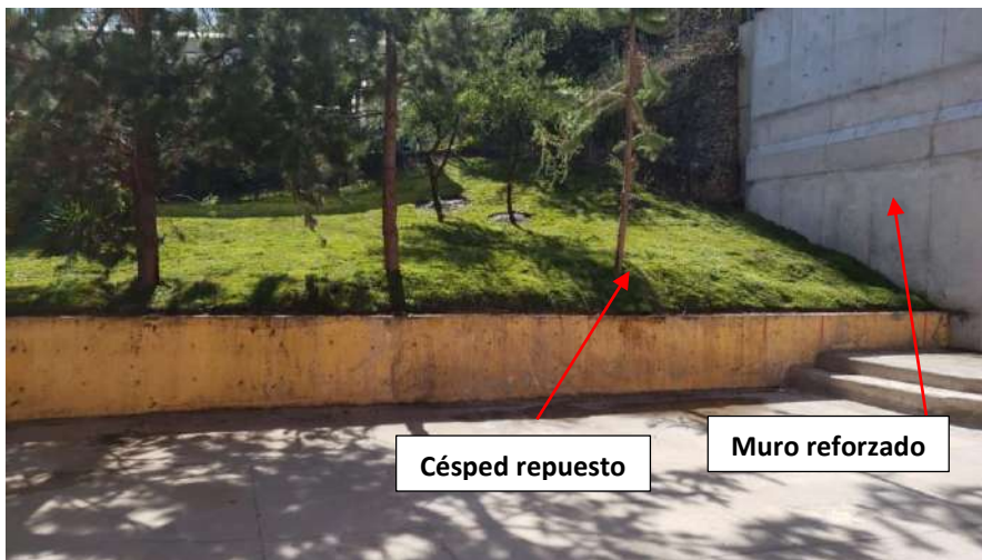
Figura: Muro de contención – Vista desde el patio del colegio
