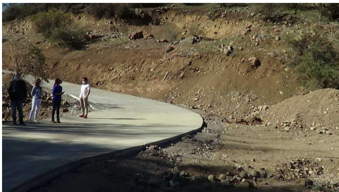
Ilustración 41 - Equipo de la visita a terreno sobre la carpeta de rodado, al lado taludes con exposición de suelo a erosión.
