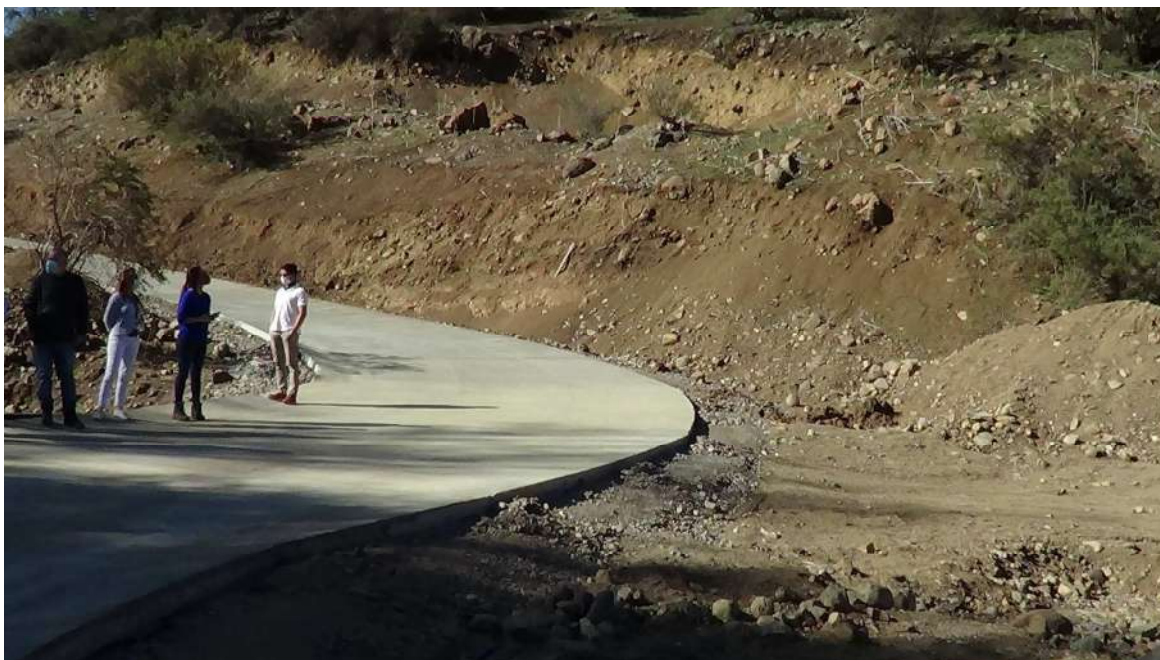
Ilustración 23 - Vista de taludes que resultan de la construcción del camino donde evidencia la exposición del suelo y el riesgo de erosión y desprendimiento en masa.
