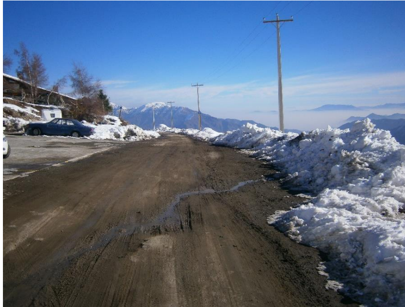
Imagen 32: Estado Actual de Vialidad en El Colorado, 30.05.2017. Fuente: Asesoría Urbana,
