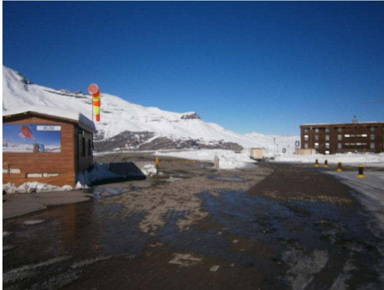
Imagen 52: Estado Actual de Vialidad en Valle Nevado, 30.05.2017.Fuente: Asesoría Urbana.
