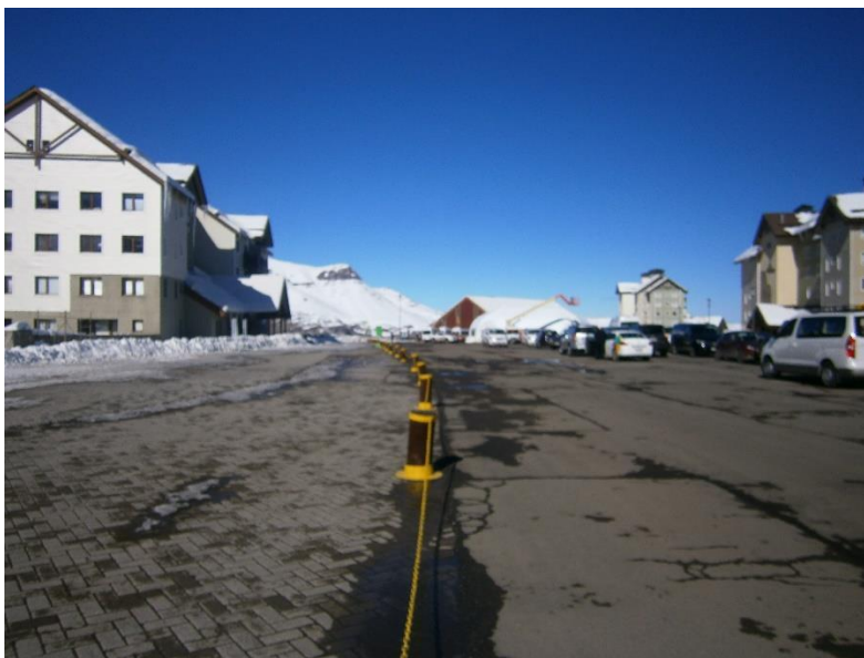
Imagen 51: Estado Actual de Vialidad en Valle Nevado, 30.05.2017. Fuente: Asesoría Urbana.
