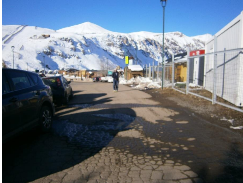
Imagen 6: Estado actual de Vialidad en Farellones, 30.05.2017. Fuente: Asesoría urbana.
