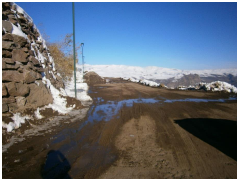
Imagen 7: Estado Actual de Vialidad en Farellones, 30.05.2017. Fuente: Asesoría urbana.
