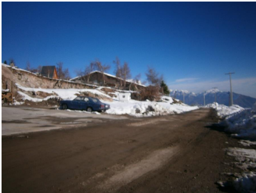
Imagen 39: Estado Actual de Vialidad en El Colorado, 30.05.2017. Fuente: Asesoría Urbana.
