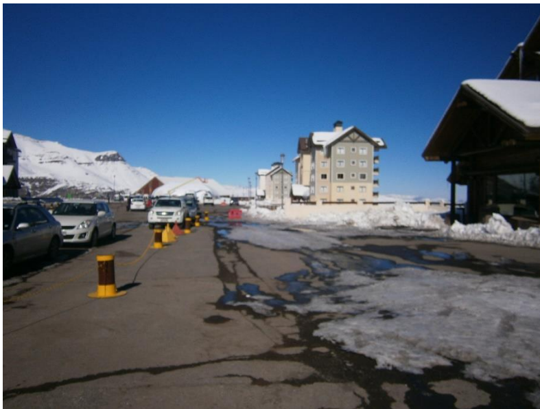
Imagen 47: Estado Actual de Vialidad en Valle Nevado, 30.05.2017. Fuente: Asesoría Urbana.
