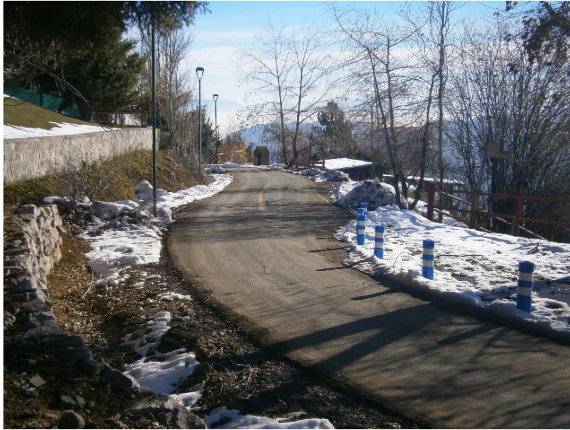
Imagen 10: Estado Actual de Vialidad en Farellones, 30.05.2017. Fuente: Asesoría urbana.
