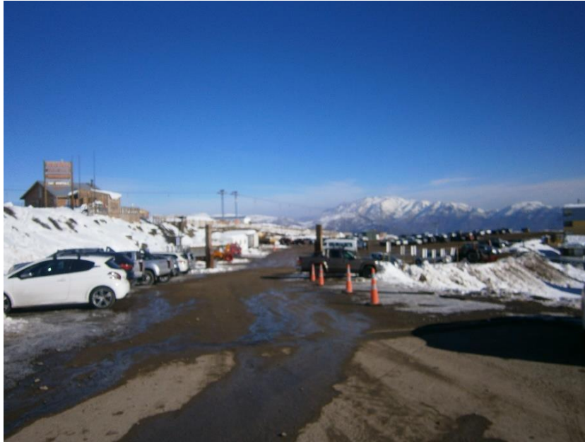
Imagen 38: Estado Actual de Vialidad en El Colorado, 30.05.2017. Fuente: Asesoría Urbana.
