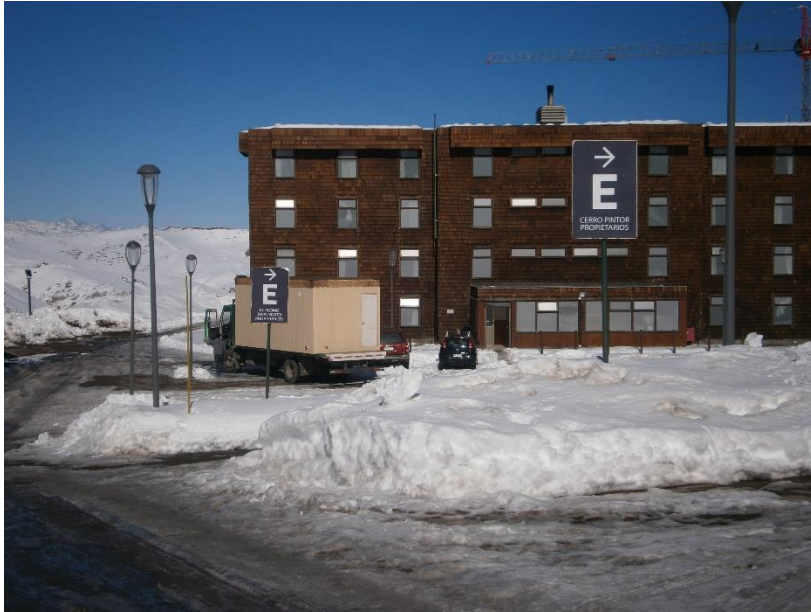
Imagen 48: Estado Actual de Vialidad en Valle Nevado, 30.05.2017. Fuente: Asesoría Urbana.
