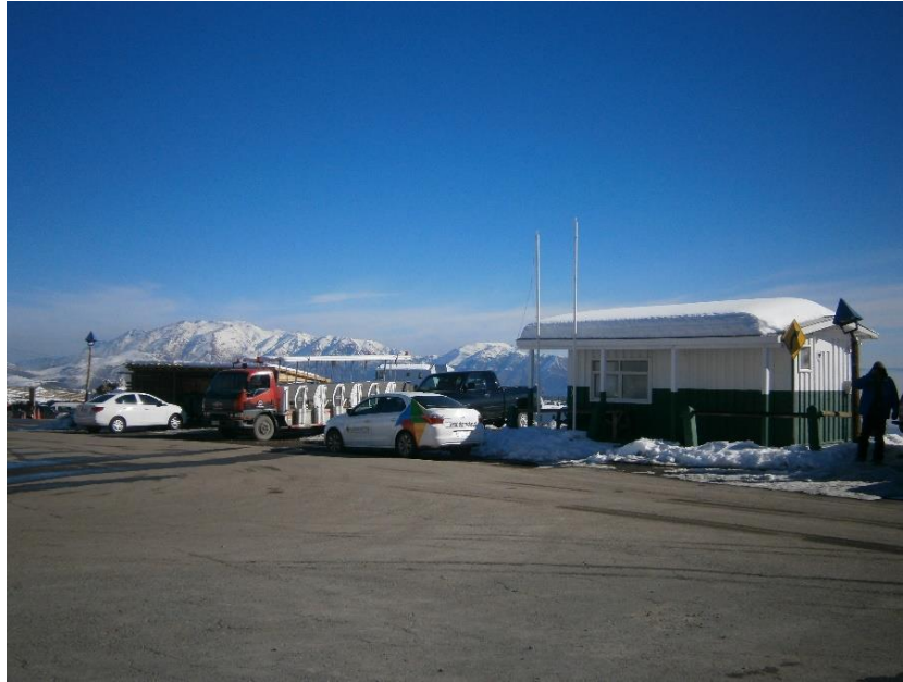
Imagen 28: Estado Actual de Vialidad en EL Colorado, 30.05.2017. Fuente: Asesoría Urbana.
