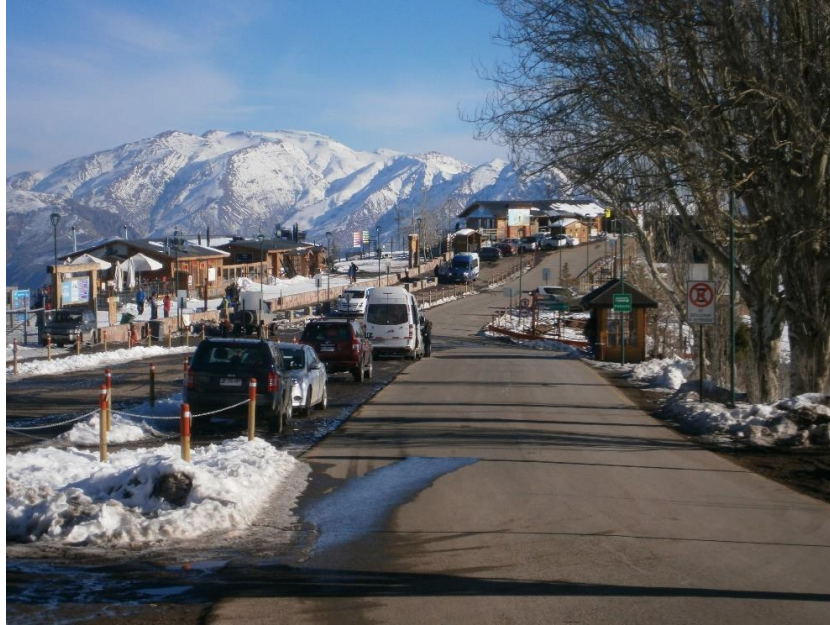
Imagen 4: Estado Actual de Vialidad de Farellones, 30.05.2017. Fuente: Asesoría urbana.
