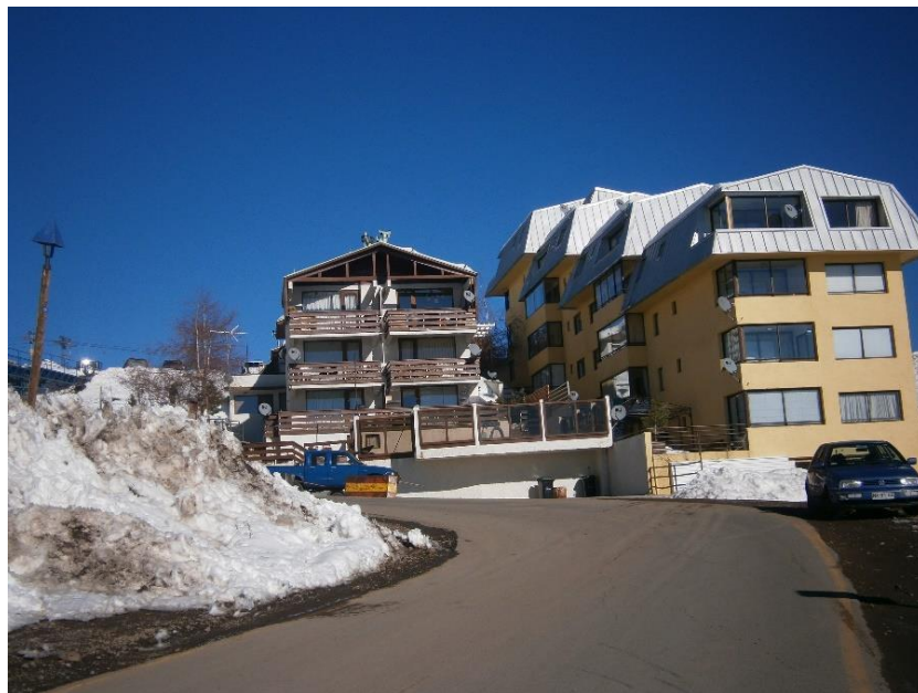
Imagen 31: Estado Actual de Vialidad en El Colorado, 30.05.2017. Fuente: Asesoría Urbana.
