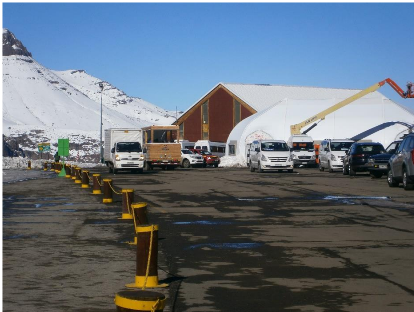
Imagen 45: Estado Actual de Vialidad en Valle Nevado, 30.06.2017.Fuente: Asesoría Urbana.
