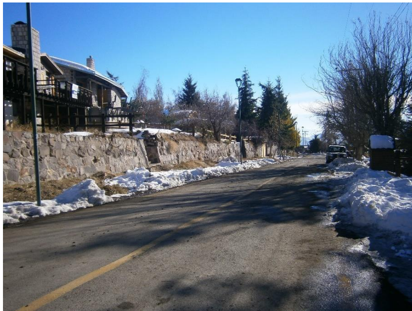
Imagen 9: Estado Actual de Vialidad en Farellones, 30.05.2017. Fuente: Asesoría urbana.
