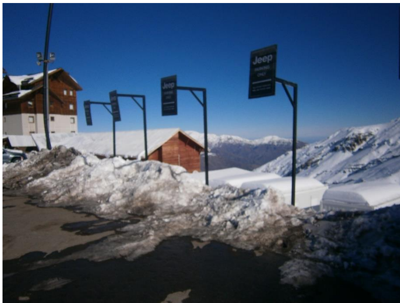
Imagen 53: Estado Actual de Vialidad en Valle Nevado, 30.05.2017.Fuente: Asesoría Urbana.
