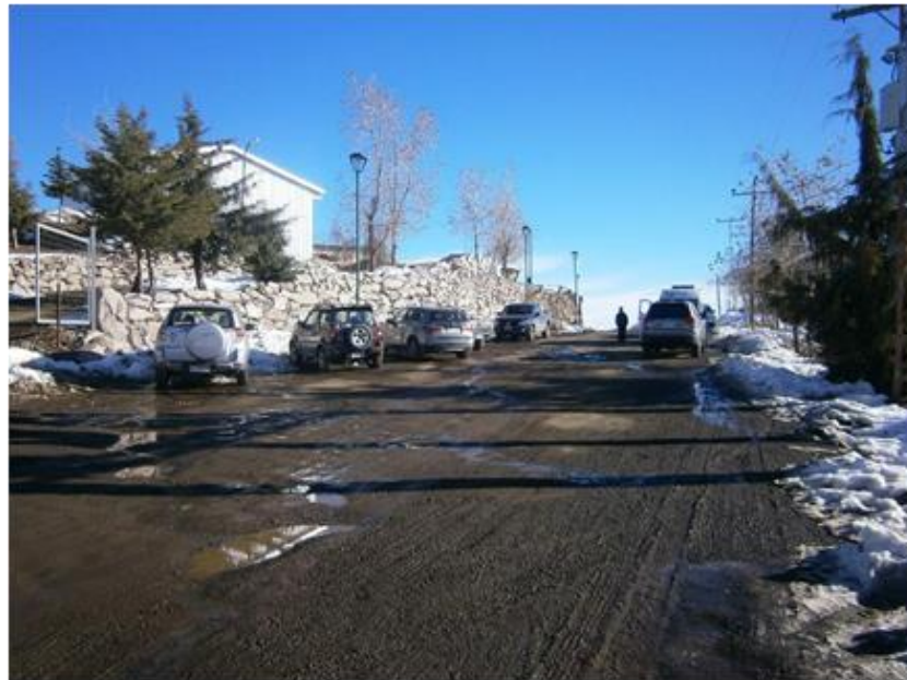
Imagen 5: Estado Actual de Vialidad de Farellones, 30.05.2017. Fuente: Asesoría Urbana.
