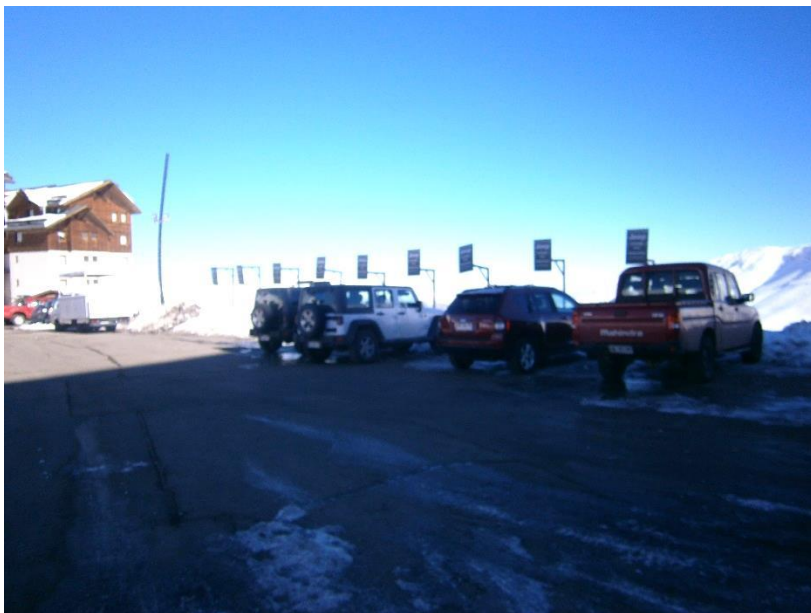
Imagen 49: Estado Actual de Vialidad en Valle Nevado, 30.05.2017. Fuente: Asesoría Urbana.
