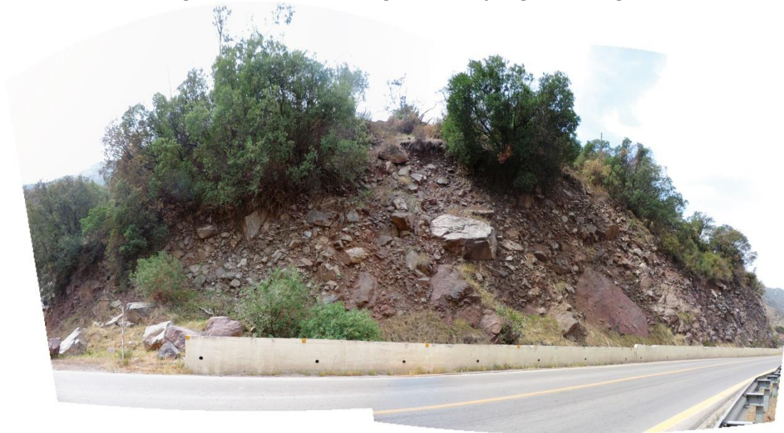
Figura Apéndice C—8 Vista en corte de los depósitos antiguos de remociones en masa en el kilómetro 10 del Camino a Farellones. Es posible distinguir bloques métricos polimícticos embebidos en un arreglo caótico de rocas fragmentadas y angulosas de granulometrías diversas.
