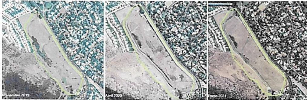
Ilustración 2-6 Evolución Obras de Canalización Quebrada El Carrizo
