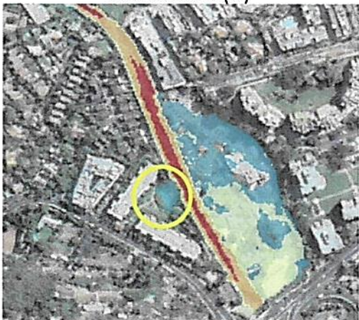
Figura 8.67 Zona de desborde 4 estero Las Hualtatas sur (t3)
