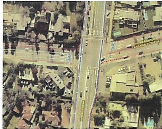
Intersección Av. La Dehesa con Av. Bernardo Larrain Cotapos
