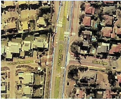
Intersección Av. La Dehesa con calle Berna
