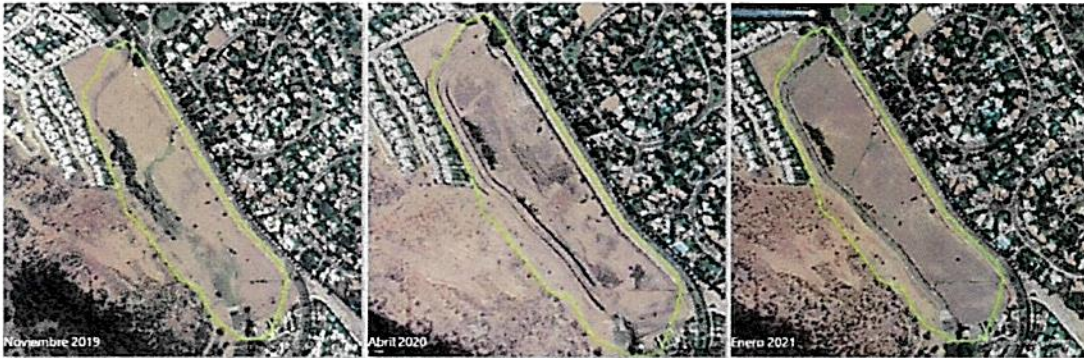
Ilustración 7-11 Evolución Obras de Canalización Quebrada El Carrizo
