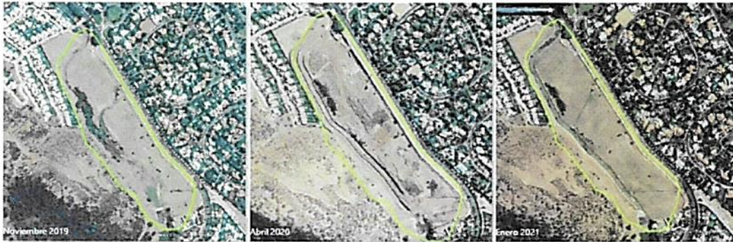
Ilustración 2-7 Evolución Obras de Canalización Quebrada El Carrizo
