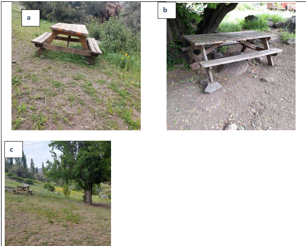
Figura 46: Estado de infraestructura sector de picnic Los Corrales.
