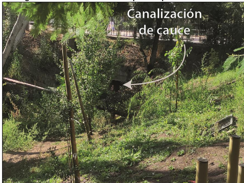
Figura 2-2 Obra de canalización para la quebrada El Gabino
