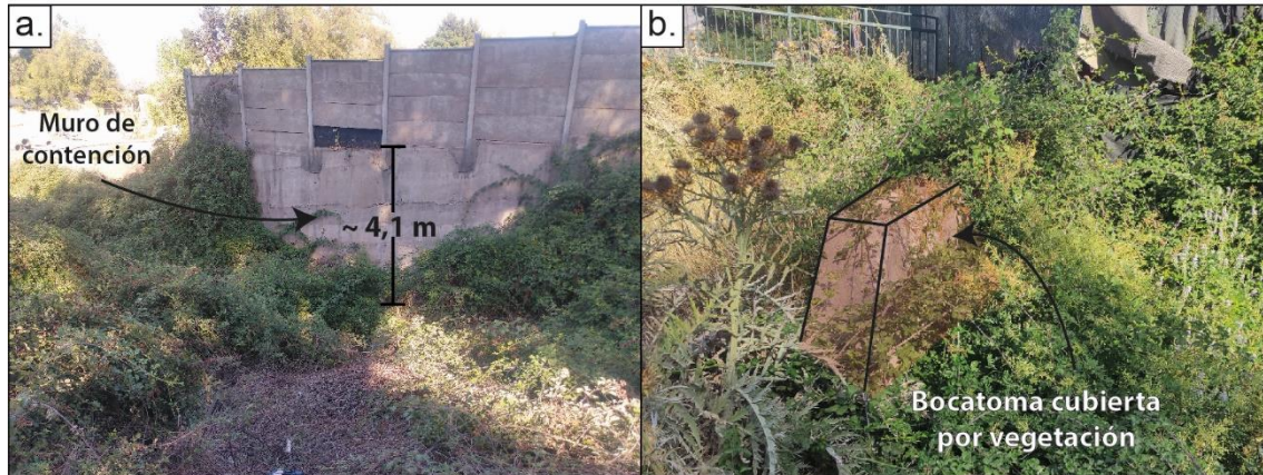
Figura 2-4 Obras de mitigación para la quebrada Los Pitufos
