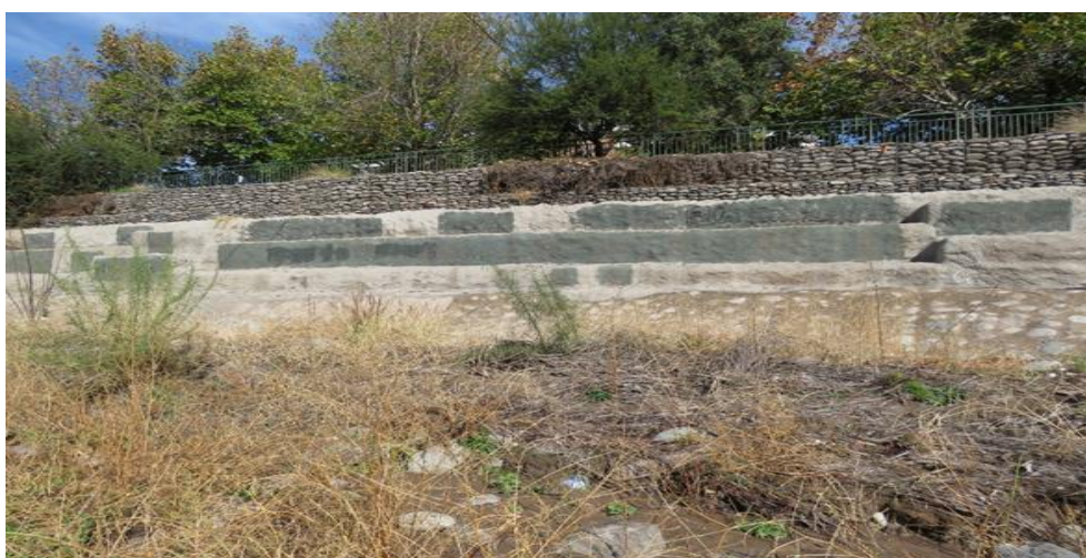
Figura 6.16 Gaviones escalonados con mallas metálicas construidos en la ribera del tramo 2.
