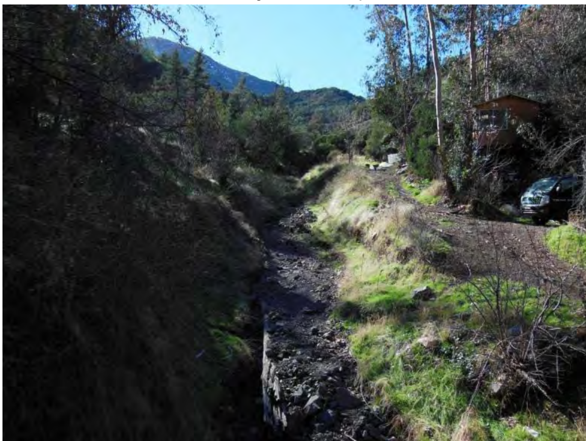
FIGURA F-1 Vista hacia aguas arriba de la Quebrada Del Ñilhue:
