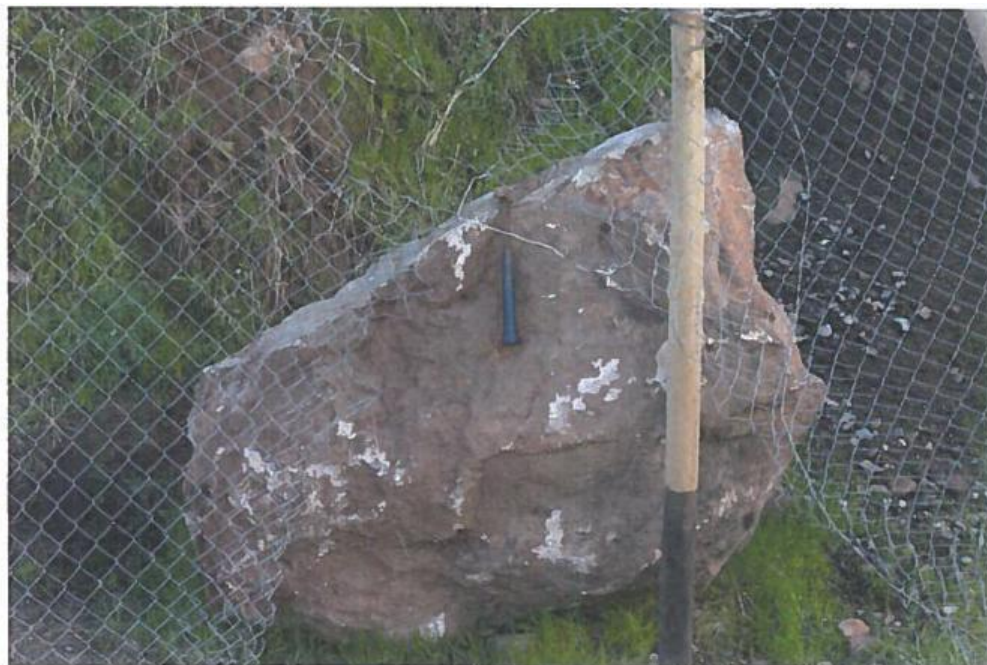
FIGURA N° 4-6 Bloque caído en sector de Aguas Claras producto del terremoto del 27 de febrero de 2010
