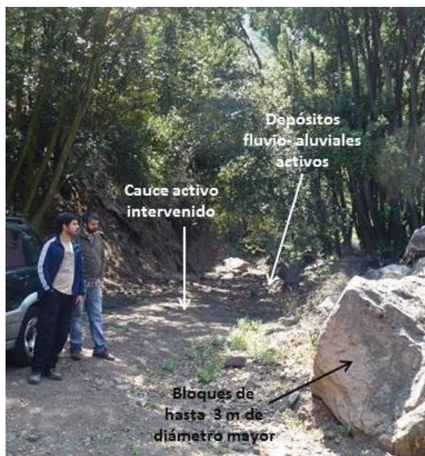
FIGURA N° 3-3 Depósitos aluviales activos en quebrada Huallalolén donde el cauce activo fue intervenido
